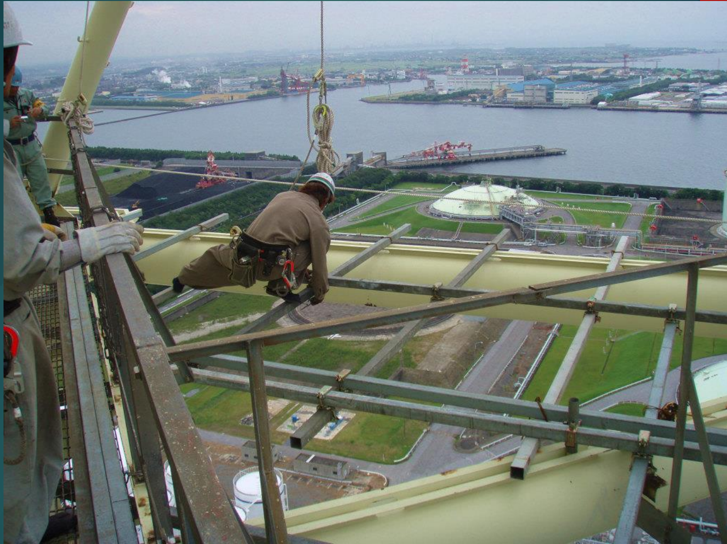
従来工法 足場の骨組みの組立て
