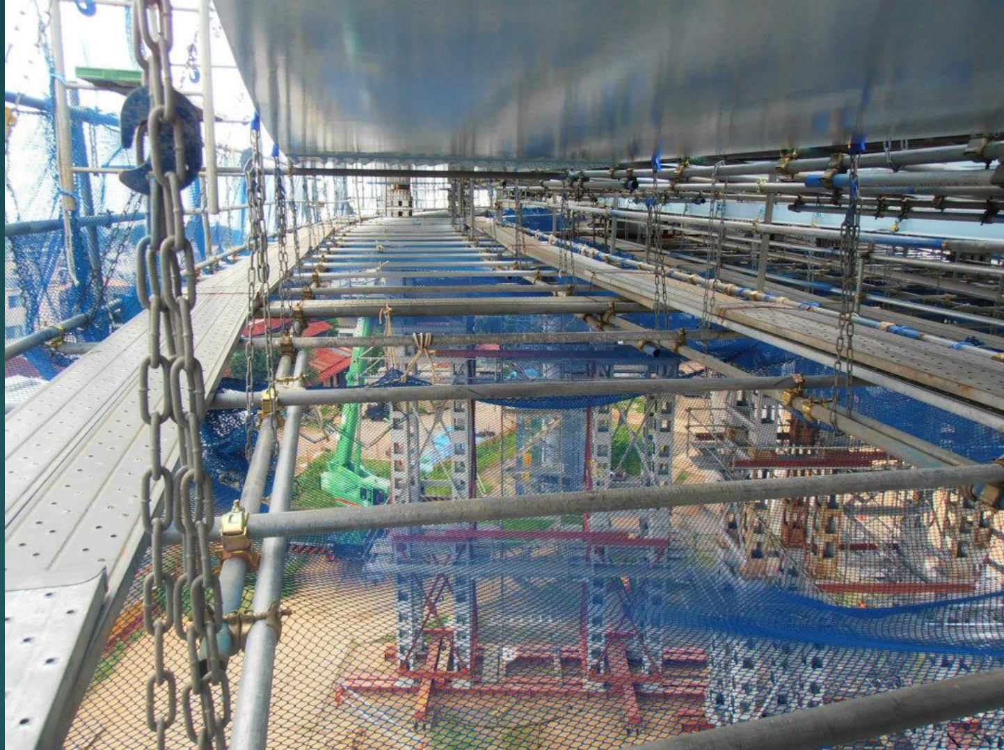
従来工法 吊り足場
