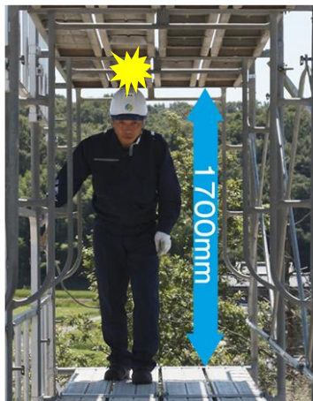
枠組(建枠)足場
