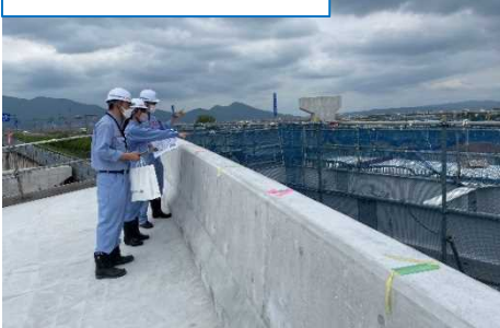
道路の現場視察
