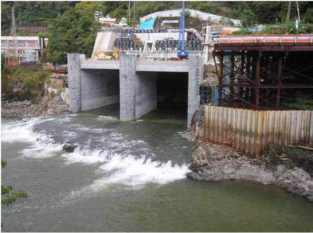
図4 通水試験時の放流状況
