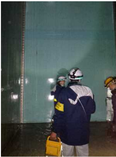
図6 副ゲートの水密性確認状況
