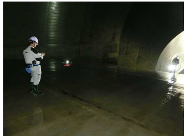
図-5 トンネル内UAV調査状況
