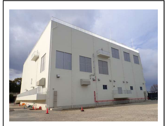
写真-9 呑龍ポンプ場
