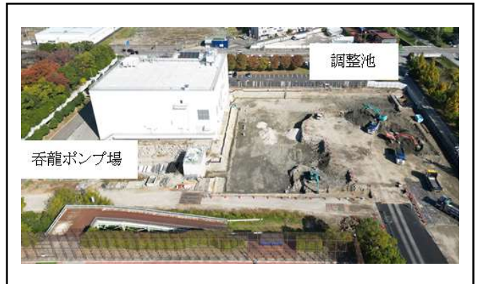
写真-5 調整池掘削状況
