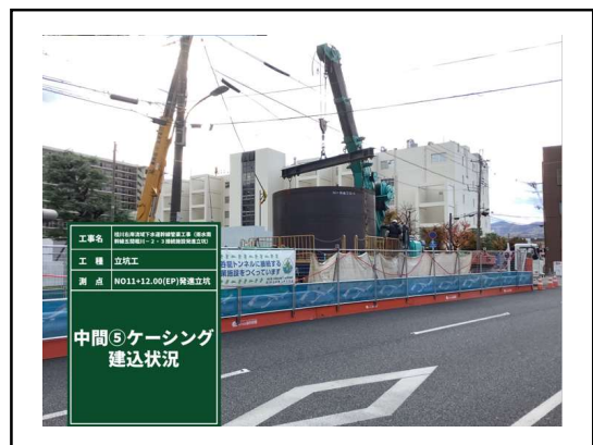
写真-6 発進立坑
