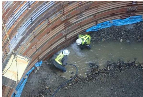
写真-1 P2橋脚の出水状況
