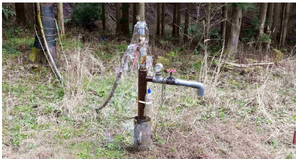
写真-2 地下水が自噴するボーリング孔
