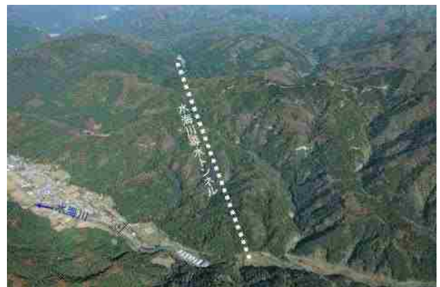
写真-1 水海川導水トンネル全景
