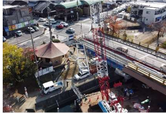
図-8 クレーン台船による上部工架設時の状況
