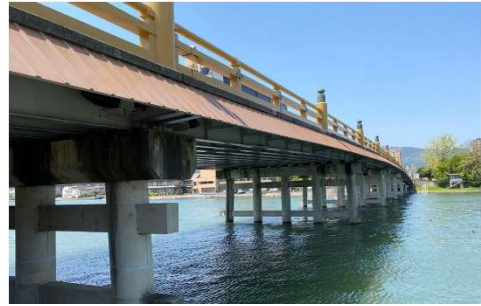
図-2 現在の瀬田唐橋
