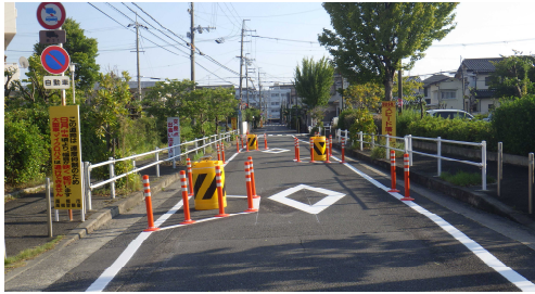
図-10 シケイン（クランク型）の設置状況
