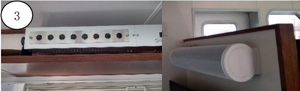
写真5 空気清浄機及びサーキュレータ
