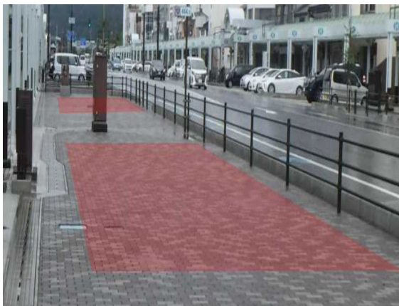
写真-4 地上物件との離隔を考慮した誘導区域のイメージ
