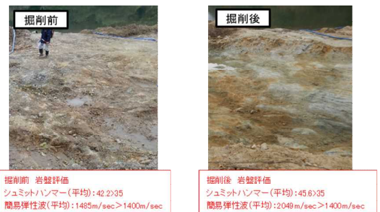
写真-4 油圧クサビ削岩 掘削前後
