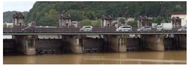
写真-1 瀬田川洗堰の全閉操作（平成25年9月16日）
