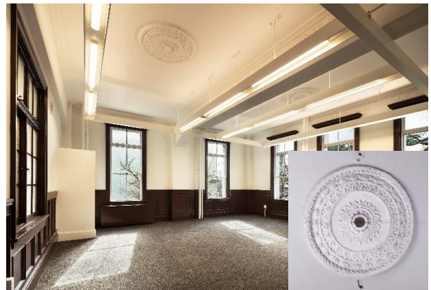
図-7 天井中心飾（左：補修・再設置後、右：補修前）
