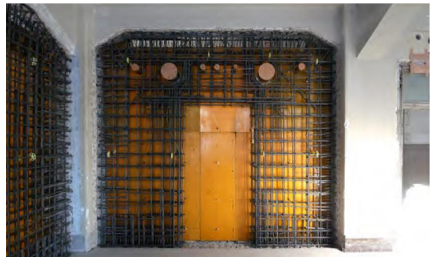
図-10 開口付き RC 耐震壁の新設（32 箇所）
