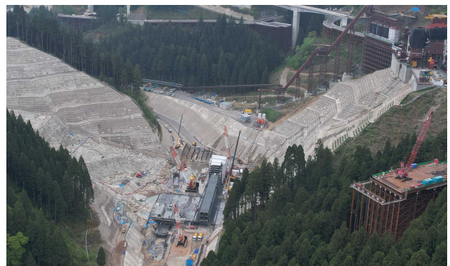
写真-1 ダム本体工事進捗状況写真（2023年4月時点）
