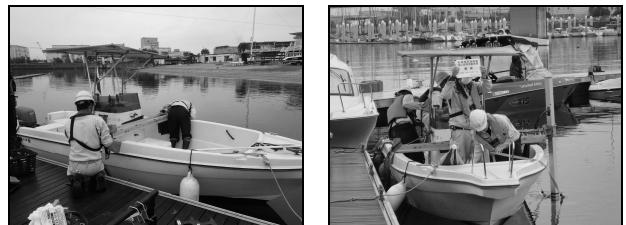
写真-2 艀装状況写真
