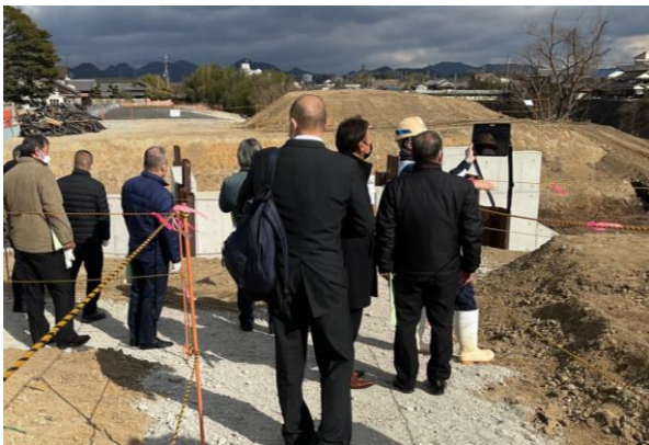
図-13 樋門施工箇所の完成イメージの共有 (AR)
