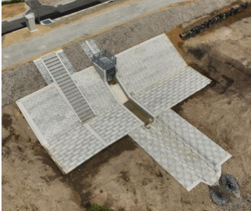
図-3 施工完了後の樋門
