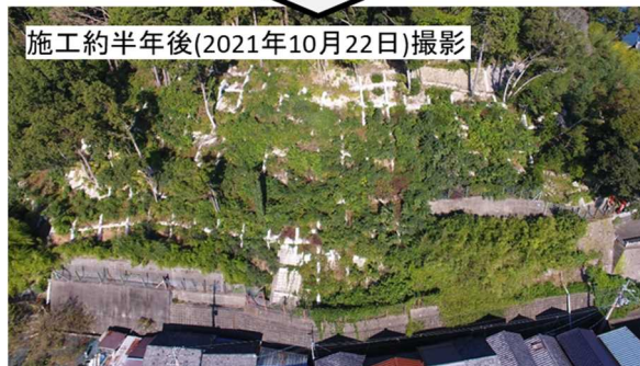
写真-4.3 B工区(下部)の植生回復状況
