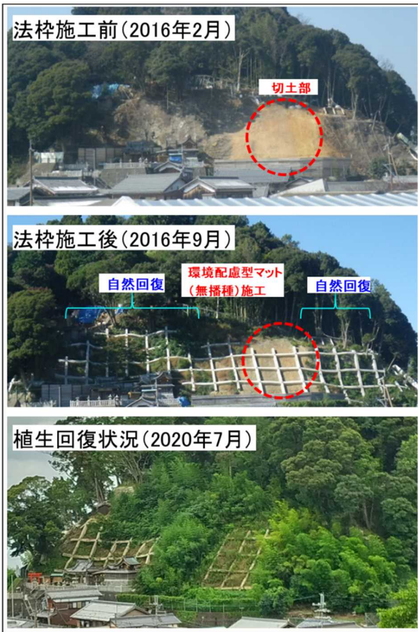
写真-4.2 C工区の植生回復状況
