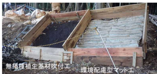
写真-3.2 試験施工の状況
