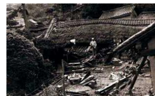
写真-2 昭和7年亀の瀬地すべりによる被害
