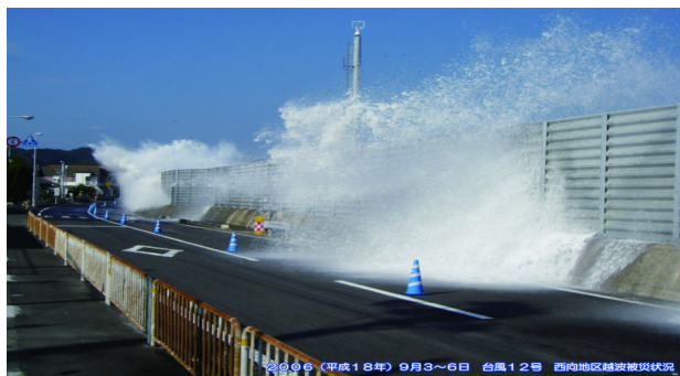
写真-2 越波対策済の越波状況
