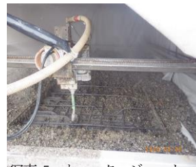
写真-5 ウォータージェット研り状況
