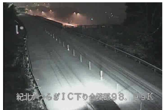
図-6 CCTVカメラによる積雪の状況
