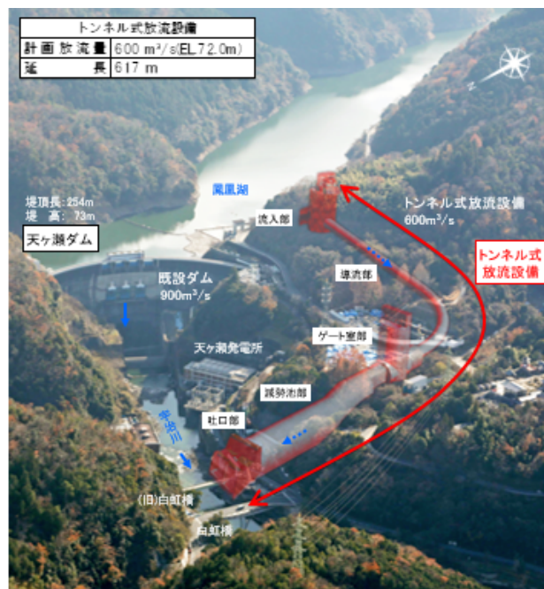
図-2 トンネル式放流設備の配置図
