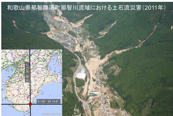
図-1 那智川流域の土石流災害
