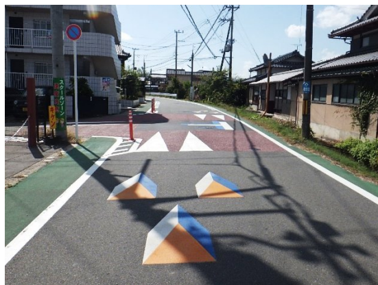
図-10 イメージハンプ設置状況
