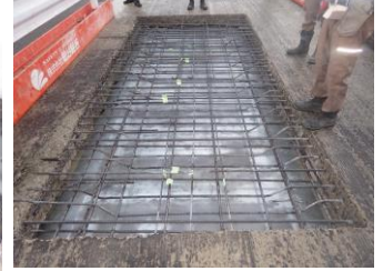
写真-6 取り壊し後
