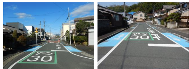
図-13 路面標示の設置状況
