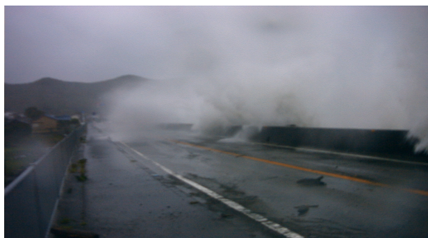
写真-1 越波対策無の越波状況
