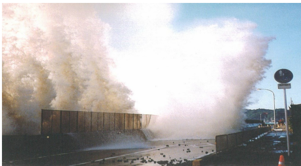
写真-3 越波防止柵を越えた越波状況
