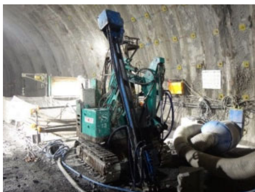
図-16 小口径深礎掘削機
