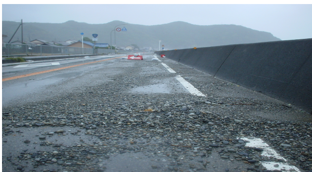
写真-4 越波が収まった後の国道42号の様子
