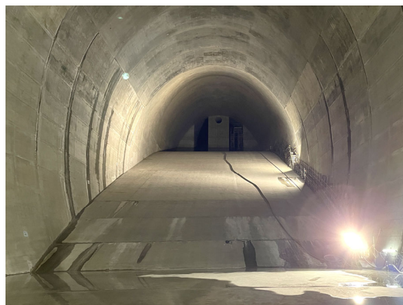
図-6 減勢池部シュート部付近 (2022年2月撮影)
