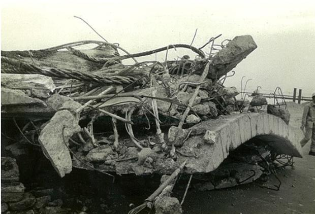
図4 被災したPC円筒セル
