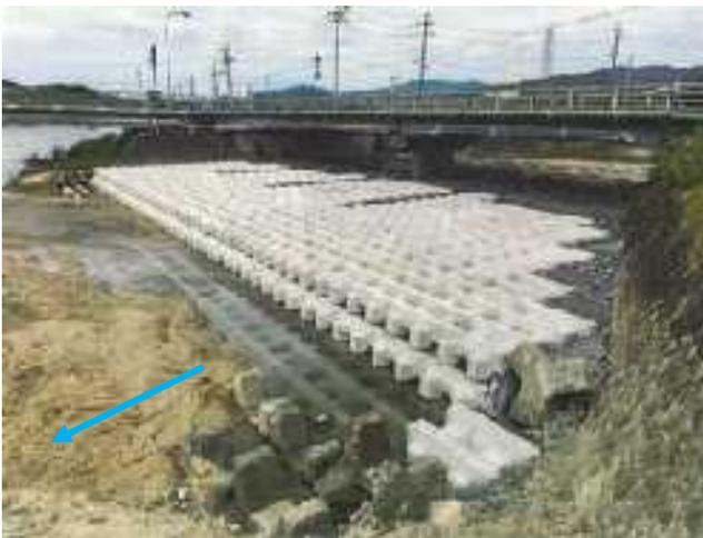
図-13 支川すりつけ工事完了写真
