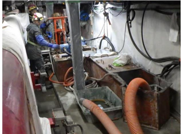
写真-8 排泥処理用設備
