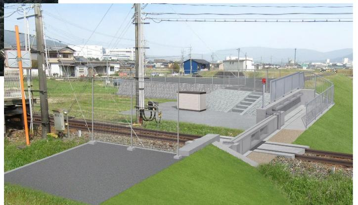
しかし、服部川の遊水地である新居遊水地及び小田遊水地を横断するように近鉄伊賀線の線路が走っており、その軌道高が遊水地を囲む周囲堤よりも低いため堤防高の不足が生じ、治水上の弱点となっていた。
