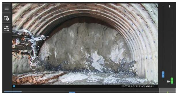
図-10 PTZカメラによる切羽撮影状況
