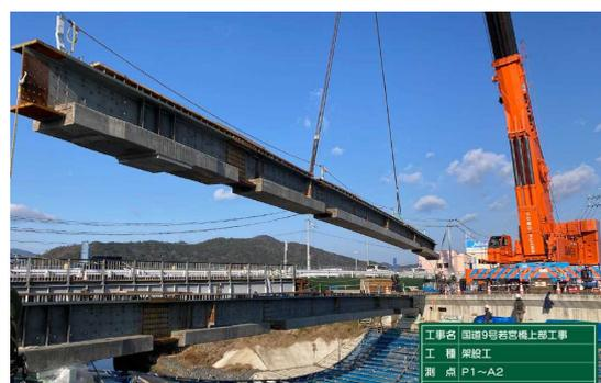
写真-9 プレビーム桁の架設 (2022年1月)
