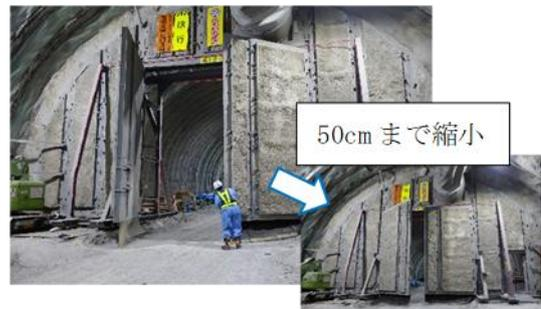
図-9 防音扉を用いた実験状況
