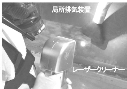
図-1 レーザークリーナーによる作業状況
