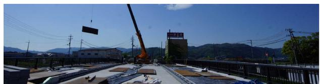
写真-13 応力開放 (リリース) 鉄板をクレーンで除荷
