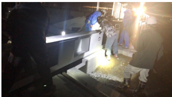
(夜間立会の様子)
