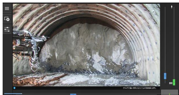
図-10 PTZカメラによる切羽撮影状況
