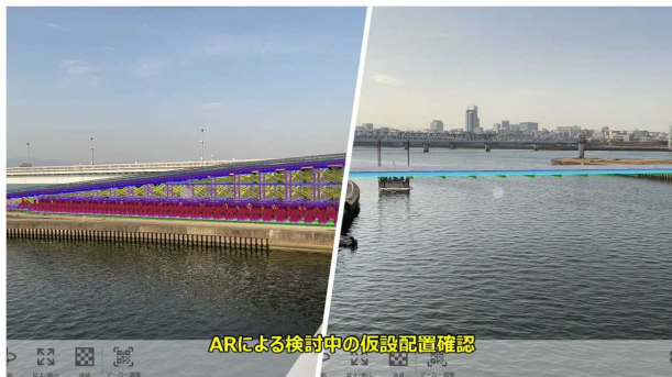
図-7 ARを用いた現場臨場 (仮設配置確認) (左：仮設スロープ、右：仮栈橋)
