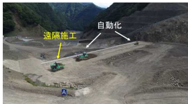
図-7 遠隔操作・自動化の施工風景
