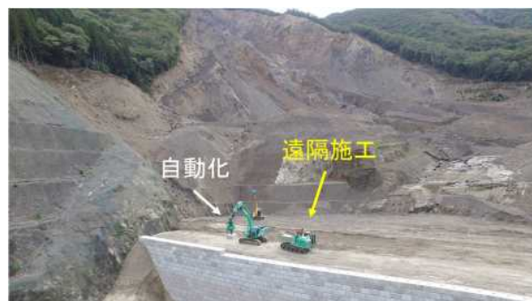
図-6 遠隔操作・自動化の施工箇所 (提供：鹿島建設)
