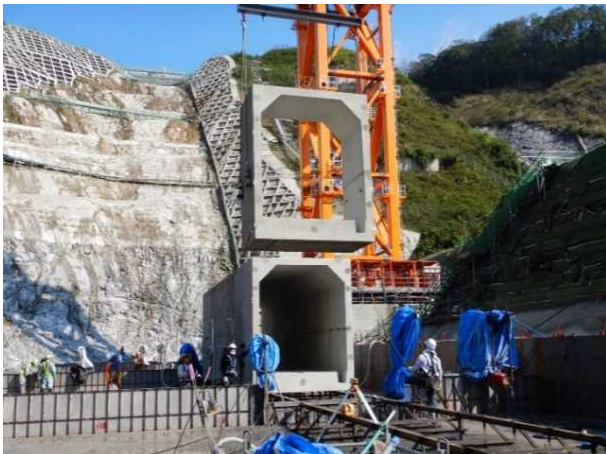
写真4 PCa部材の据付状況
