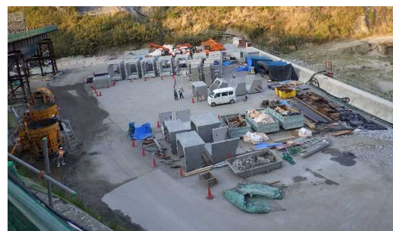
写真-2 PCa 部材ストックヤード
