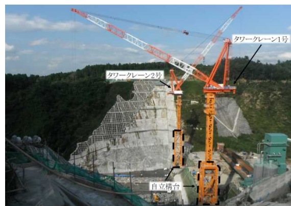
写真-3 タワークレーン運用状況
