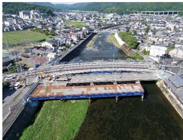
図-2 事業現況写真
