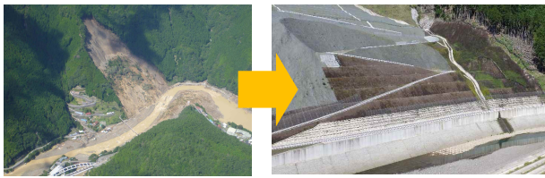
図-4 完成した清水地区（奈良県五條市）
