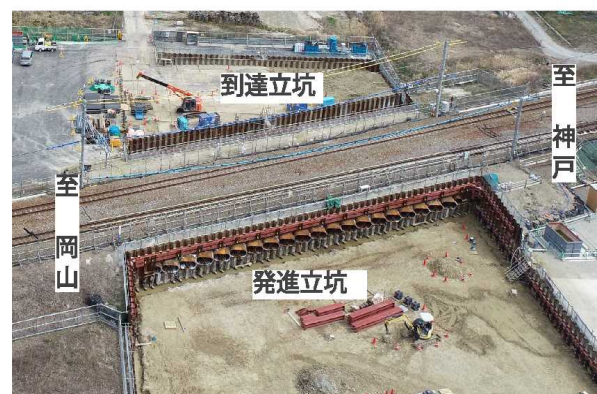
【写真-1 有年Bv工事 空撮写真 (2021.3.31時点)】
