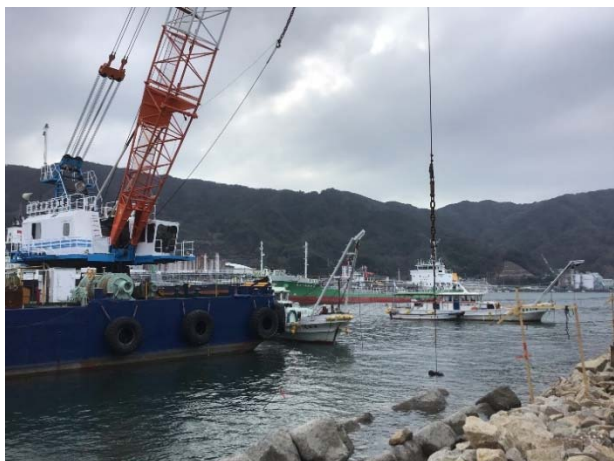
図-9 人工石据付状況
