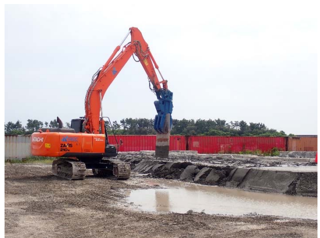
図5 人工石製作状況（条切り）
