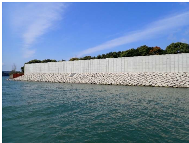
図-10 人工石据付完了状況
