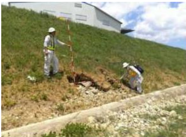
図-1 堤防点検の様子
