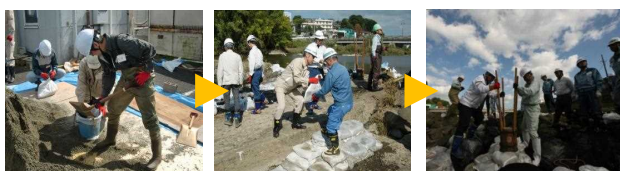
写真-11 簡易魚道設置の流れ(土嚢作成→運搬→設置)
