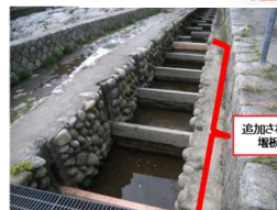
写真-6 相楽発電所取水堰魚道の改良状況
