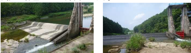
写真-12 鹿高井堰の全体図
