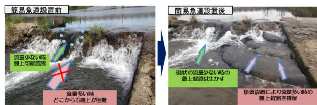
図-11 簡易改良設置前後の比較
