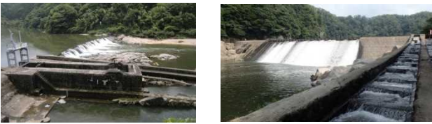
写真-3 堰全景(左:相楽発電所取水井堰 右:大河原発電所取水井堰)
