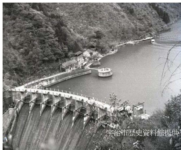
図-2 大峰ダム堰堤の様子(昭和29年4月撮影)
