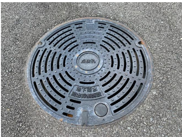
図-11 取り替え後のマンホール
