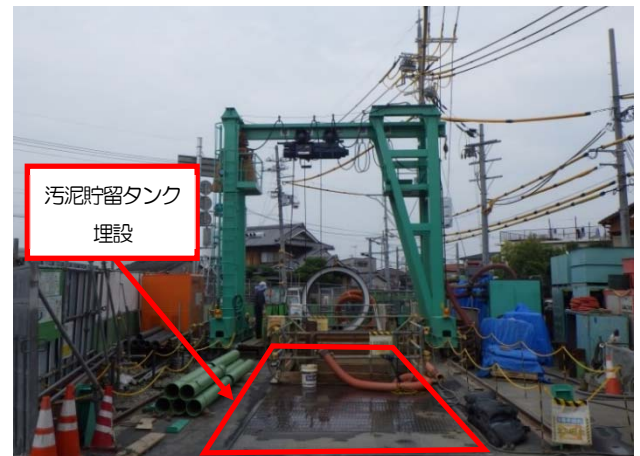
写真-5 機器（汚泥貯留タンク）埋設状況
