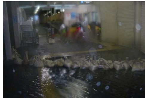
写真-1 近鉄小倉駅浸水状況
