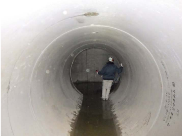
写真-6 完成した貯留管内部
