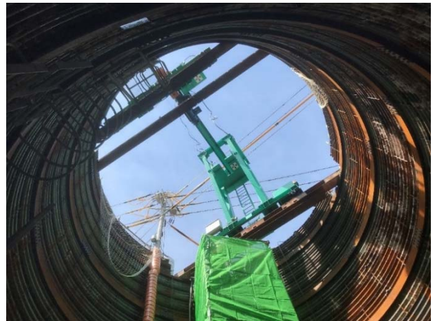
写真-4 ライナープレート内よりレール宙吊り状況
