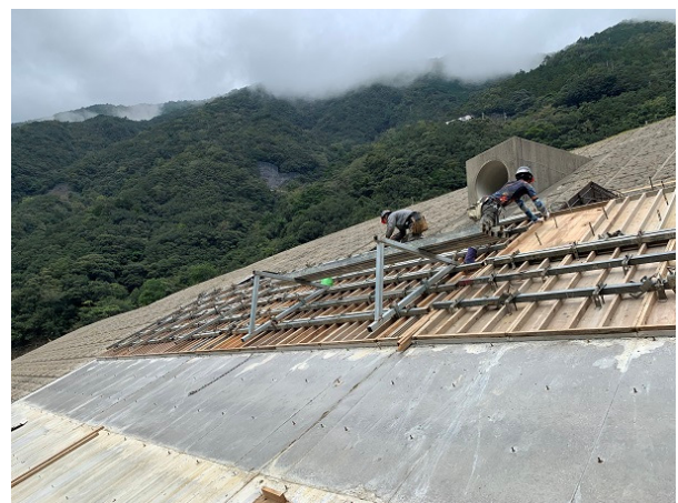
写真-8 張コンクリート工
