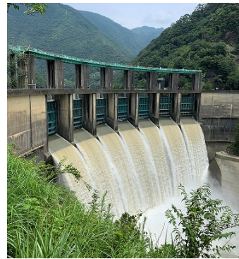
写真-6 二津野ダム放流状況(放流量:150t/s)
