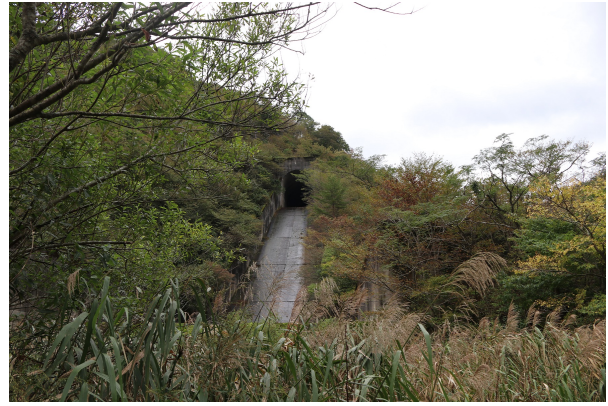
写真-8 排水トンネル(笹生川ダム)
