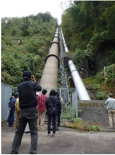
写真-5 山から下りてくる水圧鉄管 (中島発電所)
