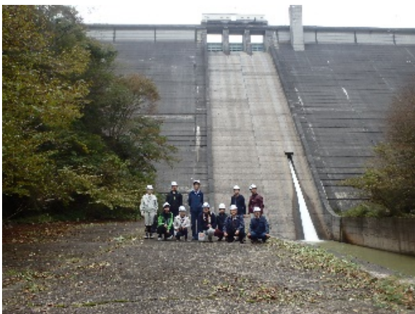
写真-7 堤体直下流(笹生川ダム)
