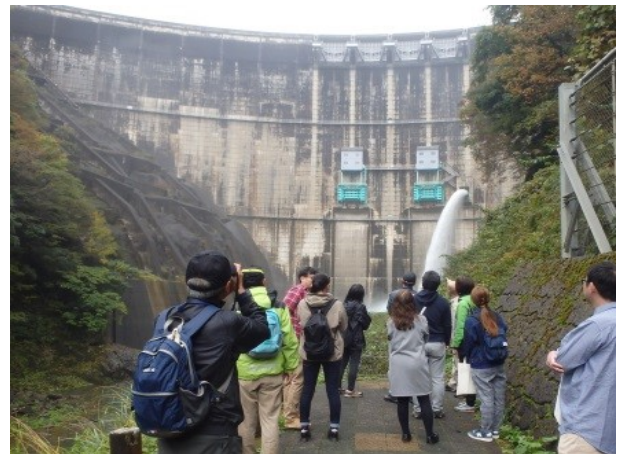
写真-3 下流面からの眺め(真名川ダム)
