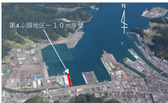
写真-1 舞鶴港第4ふ頭地区(航空写真)
