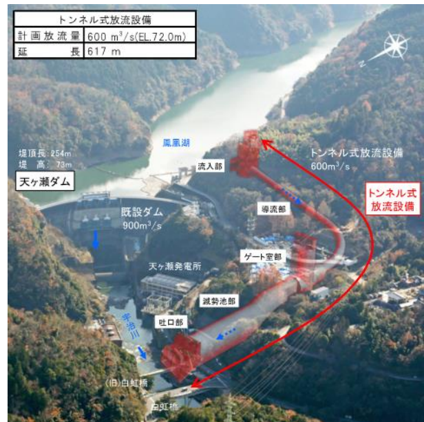
図-2 トンネル式放流設備の配置図
