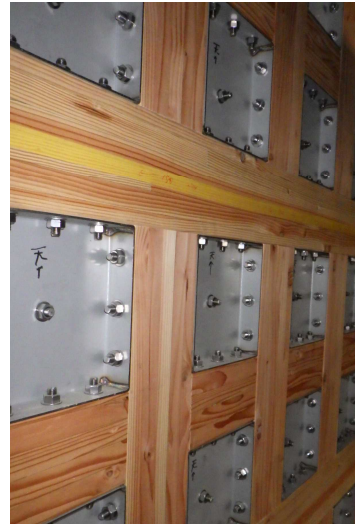
図-9 鋼板パネル補強木造格子積層壁 (2020年(令和2年)5月撮影)
