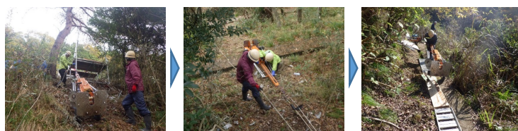
写真-3 ミニラムサウンディング試験機材の移設状況
