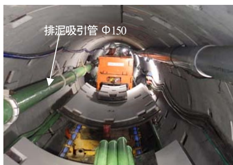
写真-1 坑内全景
