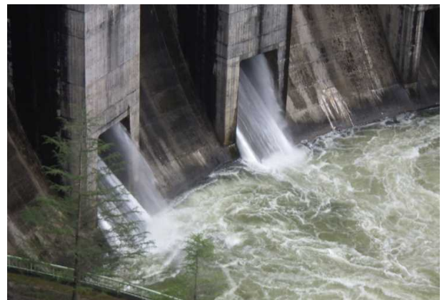
写真7 側部噴流の再発状況
