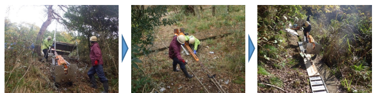
写真-3 ミニラムサウンディング試験機材の移設状況
