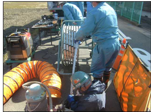
写真-3 ガイド挿入式カメラ調査状況
