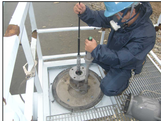
写真-4 挿入式カメラ調査状況
