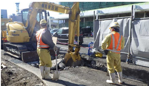
写真-5 重機と見張り員
