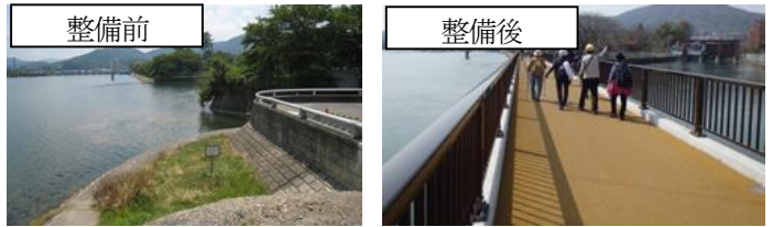
図-6 かわまちづくりで管理用通路を整備した「瀬田川ぐるりさんぽみち」
