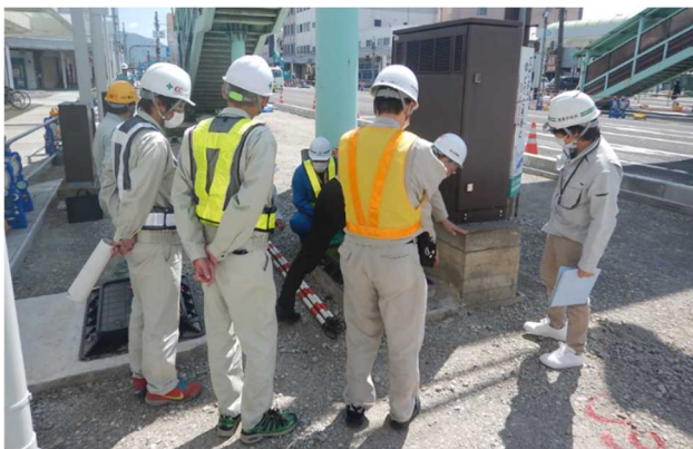
写真-11 現場確認の様子
