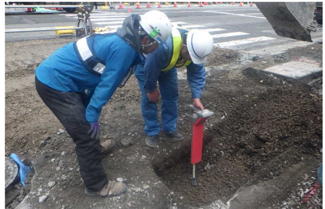
写真-9 埋設管調査
