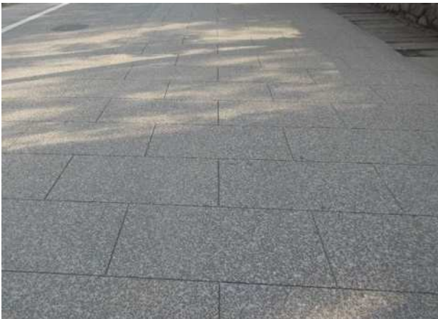
写真-3 石畳風アスファルト舗装
