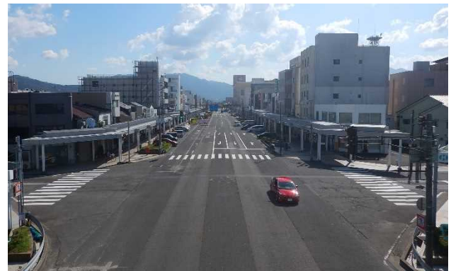
写真-1 本町通り（本町交差点から撮影）
