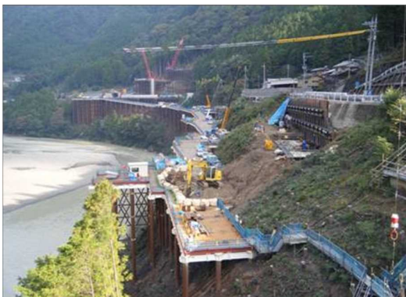
写真-2 進入路施工状況
