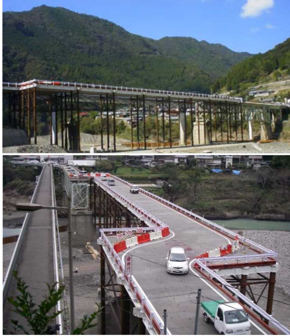
写真-11：折立橋応急復旧状況
