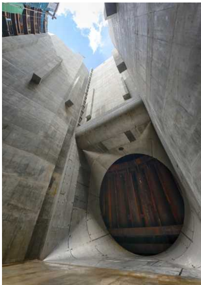
図-16 構築完了後の流入部（立抗内より）
