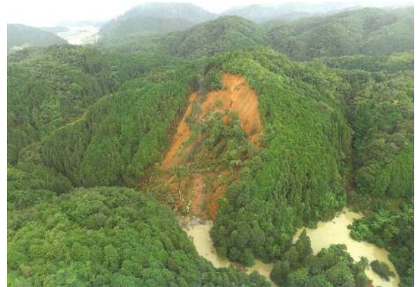
図-2 被災後の谷河川（2018年7月8日）
