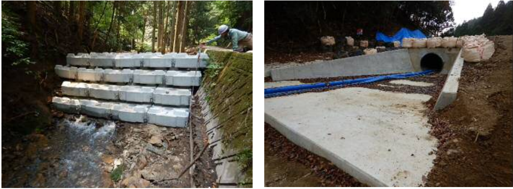
図-9 応急対策工事の状況
