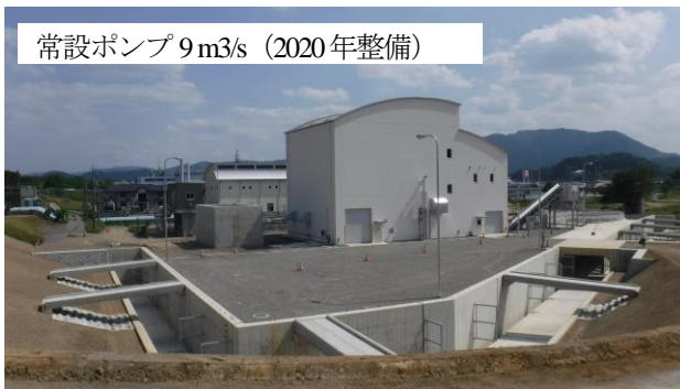
図-11 弘法川排水機場
