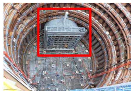
図-11 分岐配管設置状況
