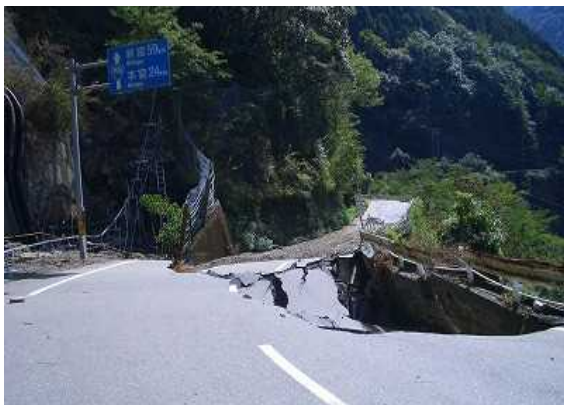
写真-5 2工区に並行する国道168号で道路崩壊が発生
