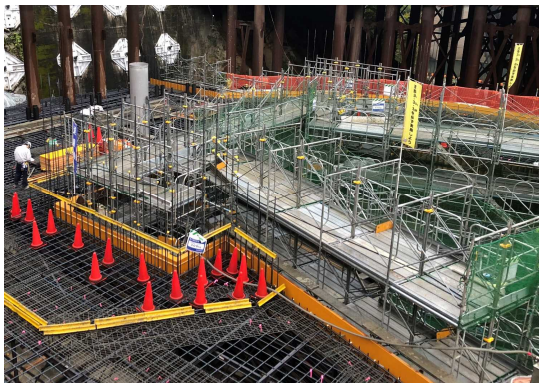
図-12 作業架台設置状況
