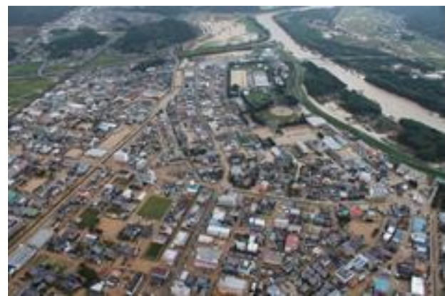
図-6 浸水状況写真 (2014年8月豪雨) (図-5の①の方向)
