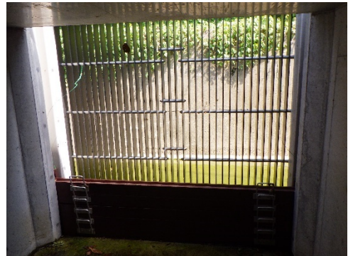
写真-4 取水口堰板
