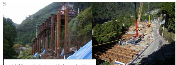
現道の谷側へ張出し架設
