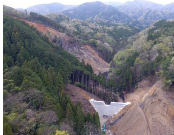
図-16 工事中の状況（2020年4月末撮影）
