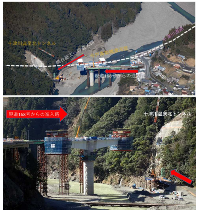
写真-13：今戸高架橋施工状況
