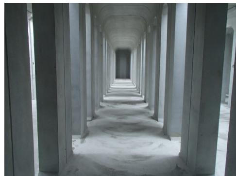
写真-2 貯留施設(伊勢田小学校)
