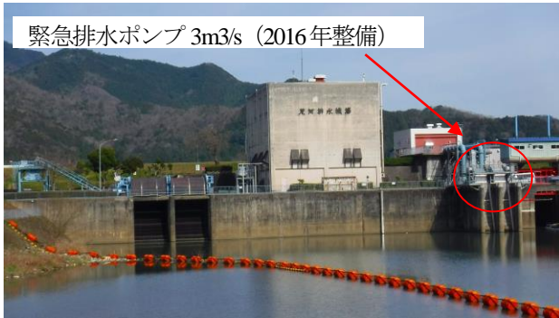
図-10 荒河排水機場
