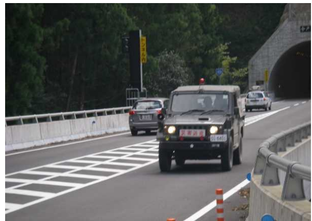
写真6 緊急開通した十津川道路
