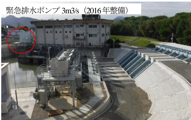
図-12 整備後の状況写真（法川排水機場）
