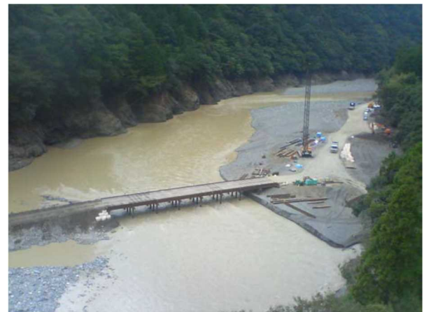
写真-9 河川側への進入路構築
