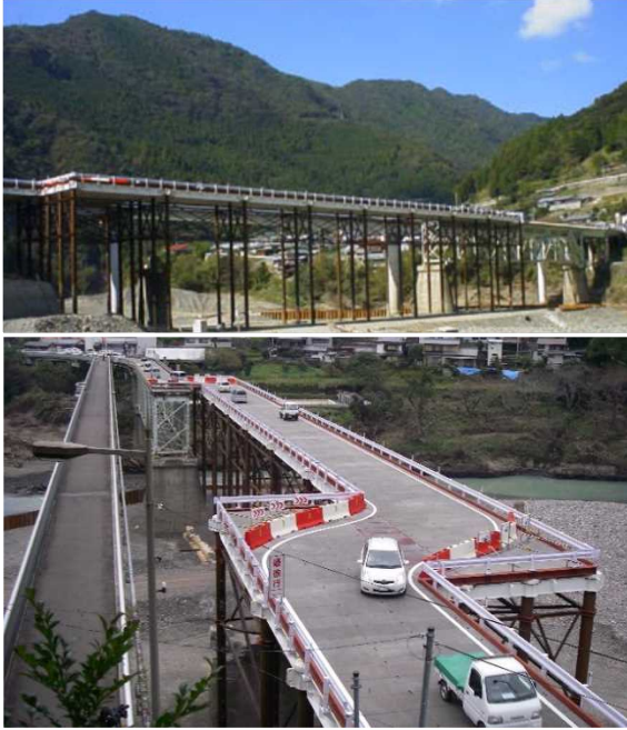
写真-11：折立橋応急復旧状況
