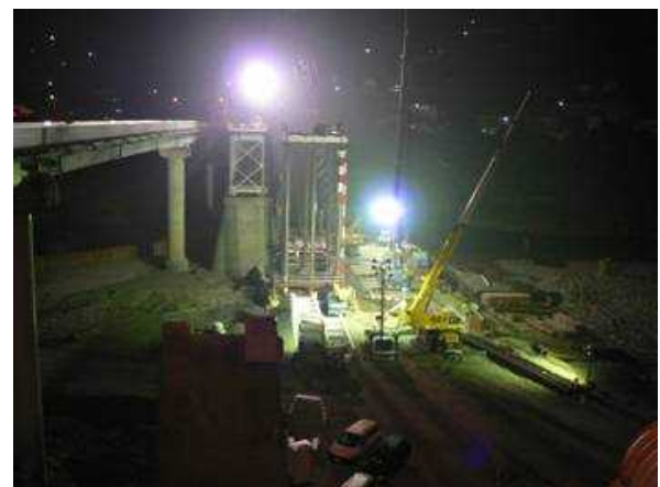
写真-10 24時間体制での復旧作業
