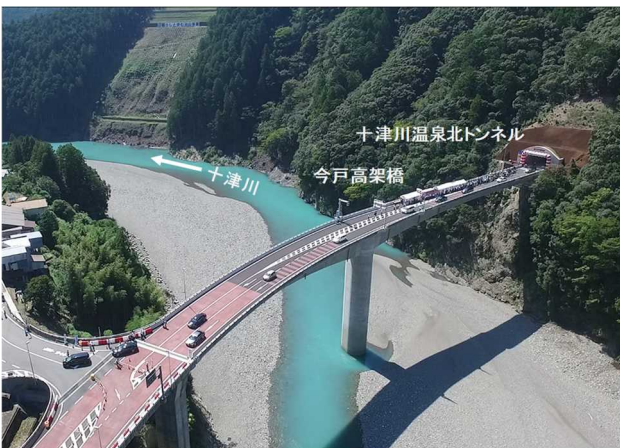
写真-15 今戸高架橋渡河部を上空から望む
