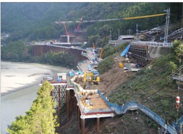
写真-2 進入路施工状況
