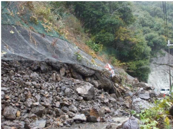
写真-12 起点側坑口予定地付近での法面崩落
