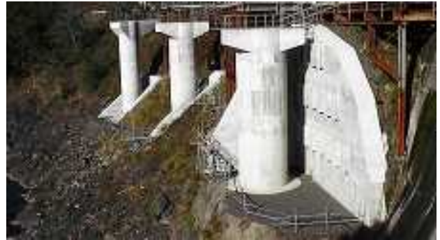
写真-3 掘削が最小限となる工法の採用
