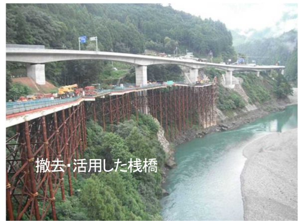
写真-8 今戸高架橋の工所用栈橋
