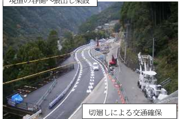
写真-4 栈橋活用による現道切廻し状況
