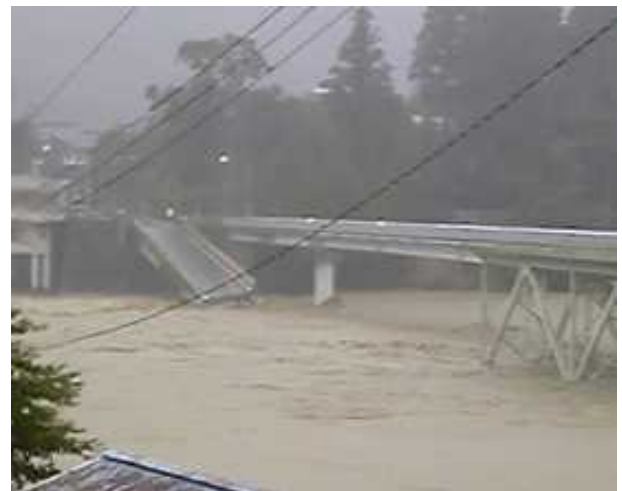
写真-7 国道168号折立橋が落橋
