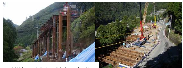
現道の谷側へ張出し架設
