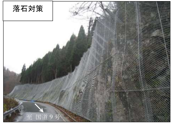
写真-1 対策工事の完成写真
