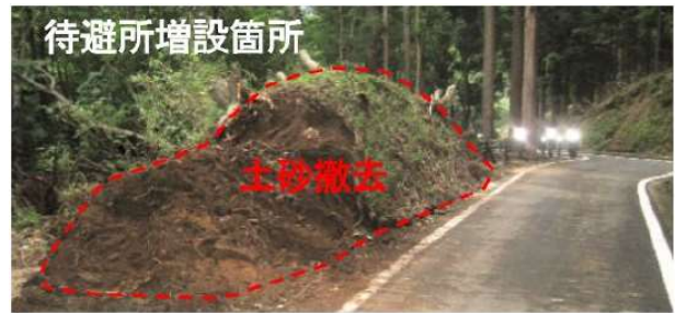
写真-5 待避所増設箇所状況
