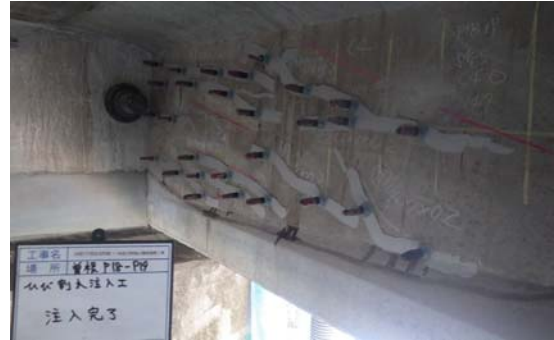
写真-5 ひび割れ注入状況
