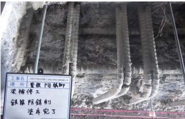
写真-8 フレア溶接、鉄筋防錆処理完了
