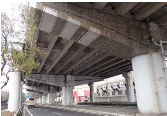
写真-1 曾根高架橋 (P16付近)
