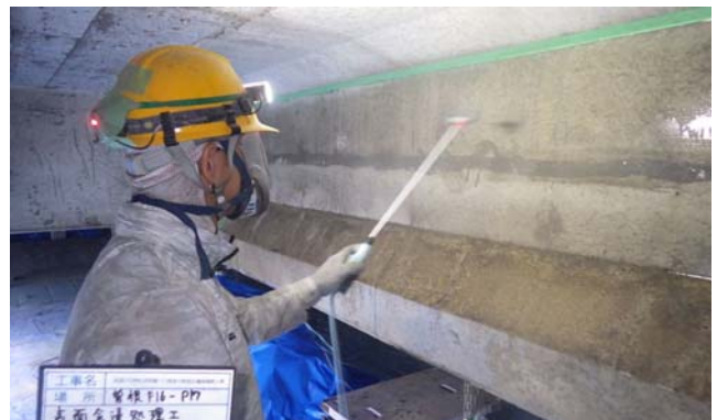
写真-6 表面含浸処理状況
