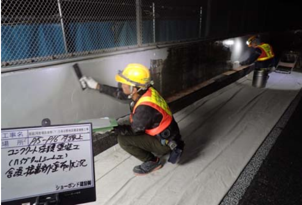
写真-7 コンクリート保護塗装工(シート系)
