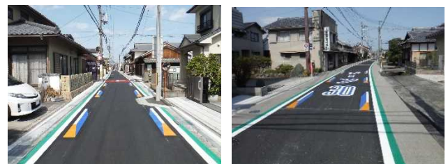
図-5 立体路面標示による狭さくと路側帯のカラー舗装
