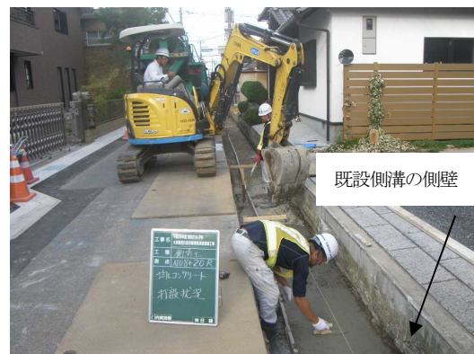
図-8 既存側溝の側壁を残しての施工状況
