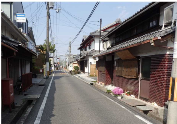
図-1 沿道の状況（施工前）
