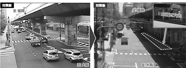
図-14 対策D 車線運用変更（1車線ゼブラ化）
