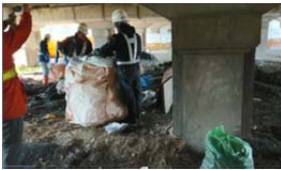
写真-9 放置物件撤去状況
