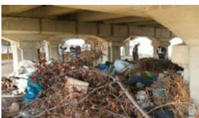
写真-13 撤去前状況
