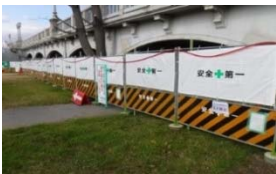
写真-11 仮囲い設置完了
