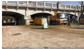
写真-10 放置物件撤去状況
