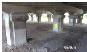
写真-14 撤去後状況
