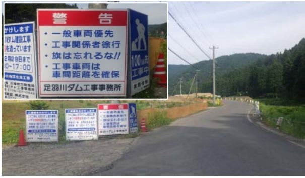
図-8 徐行看板等の設置状況
