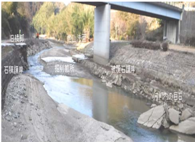
写真-4 施工箇所の河川状況
