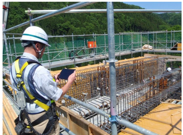
写真-2 施工管理状況
