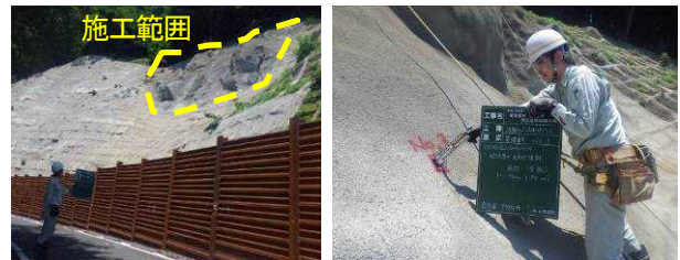
写真-1 法面対策工事における出来形計測の様子
