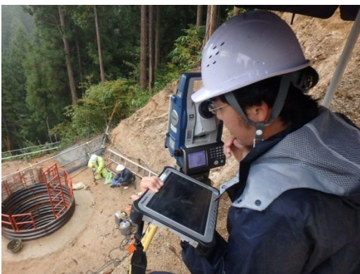
写真-3 TS測量状況
