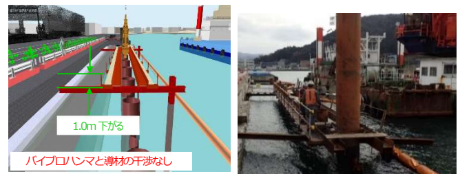
図-8 対策及び現場での施工状況
