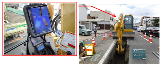
図-7 ICTバックホウによる掘削状況
